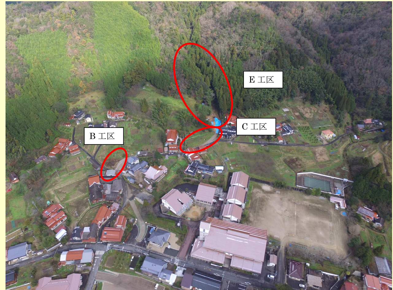
工事区域全景
