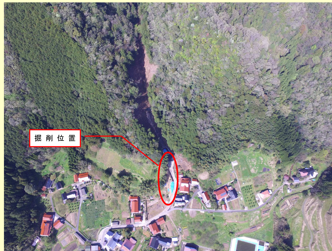
工事区域全景
