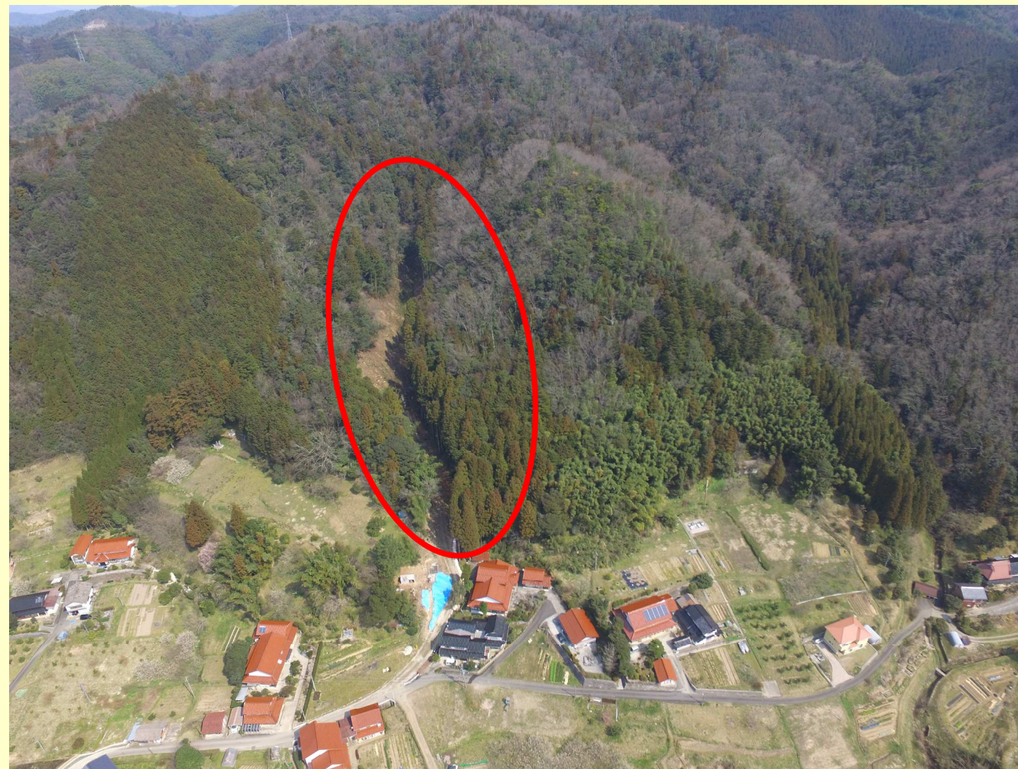
工事区域全景
