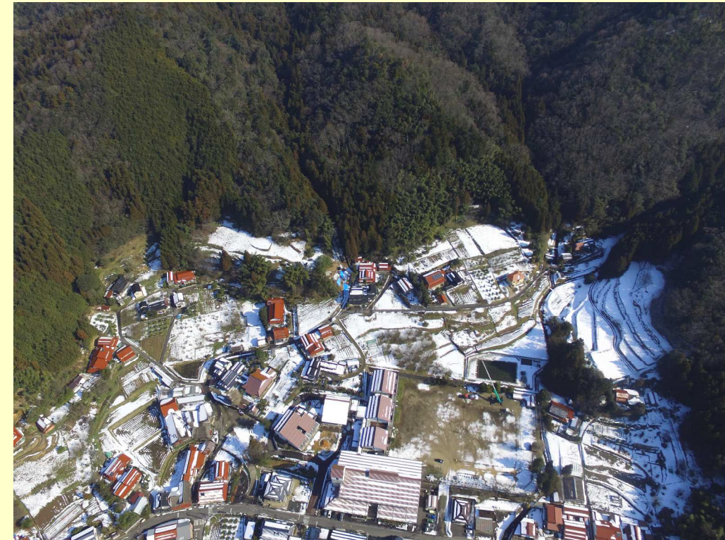
工事区域全景
