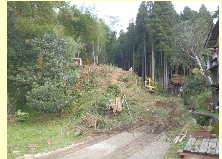
伐採作業状況
