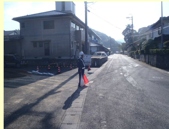
交通誘導員の配置
