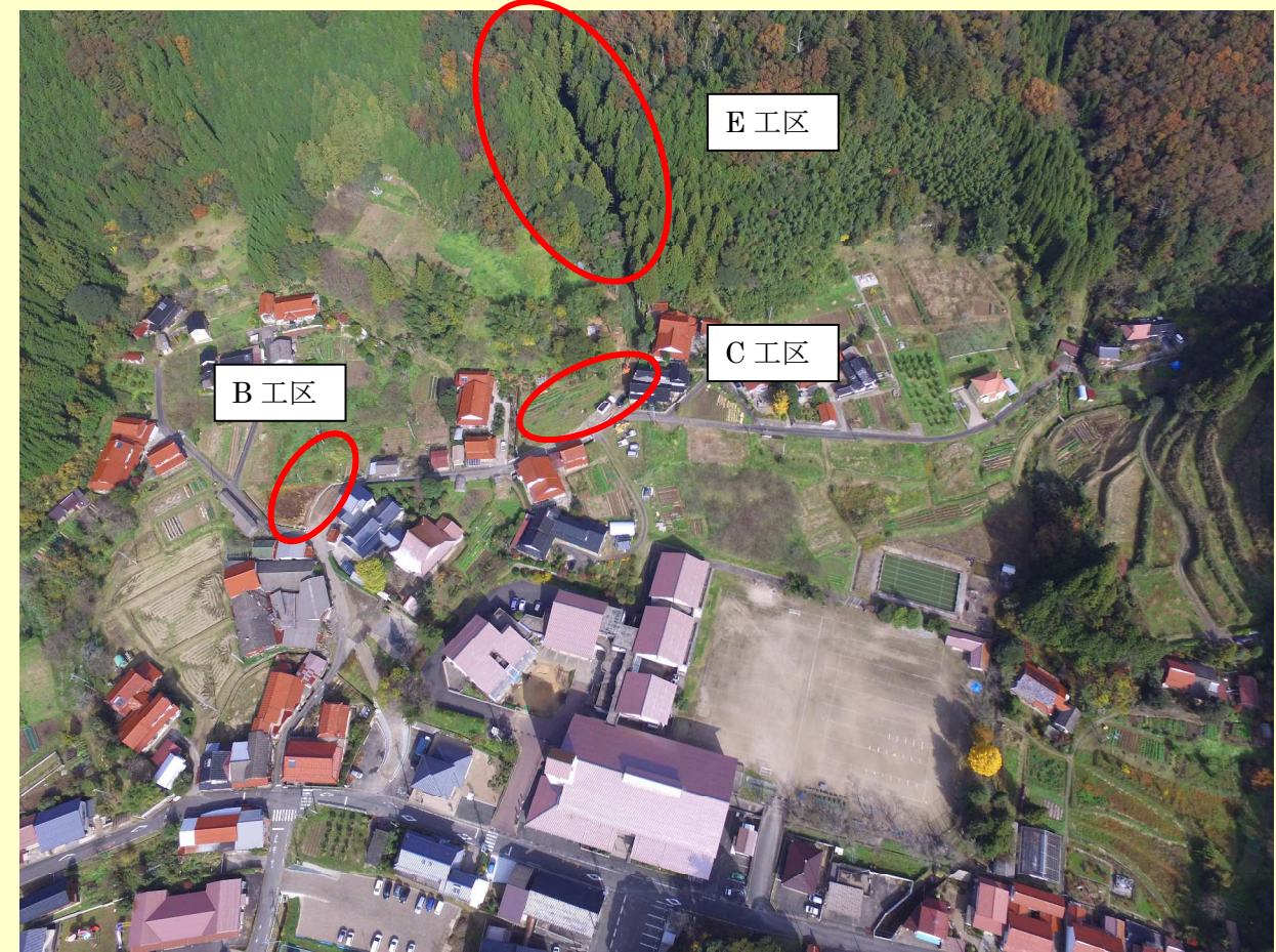
工事区域全景
