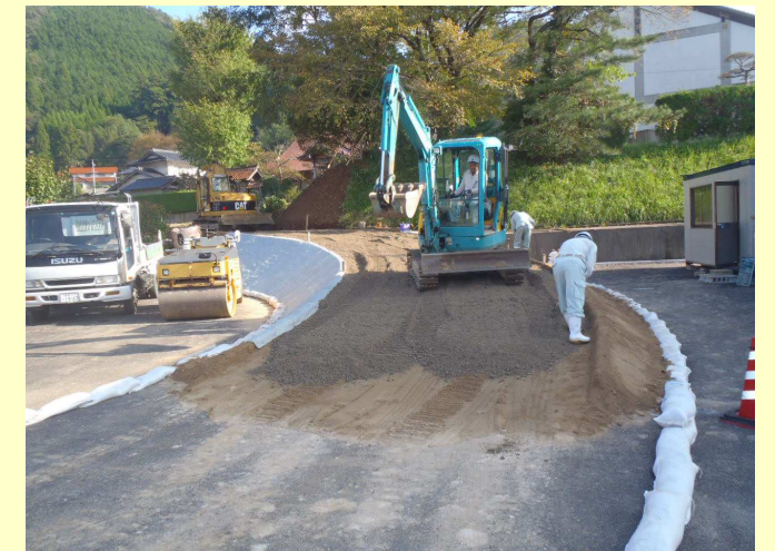
工事用道路【A 工区】作業状況
