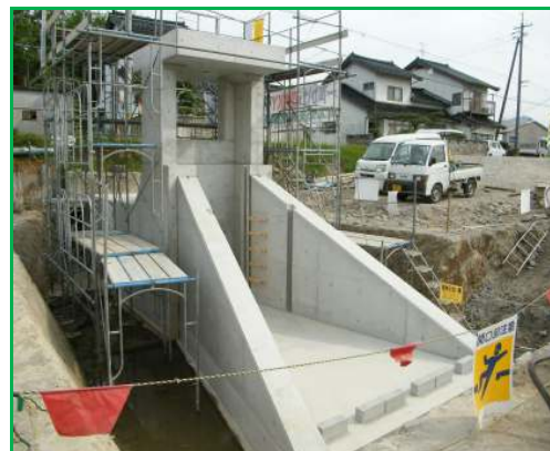
4、浜揚水機場コンクリート打設完了
