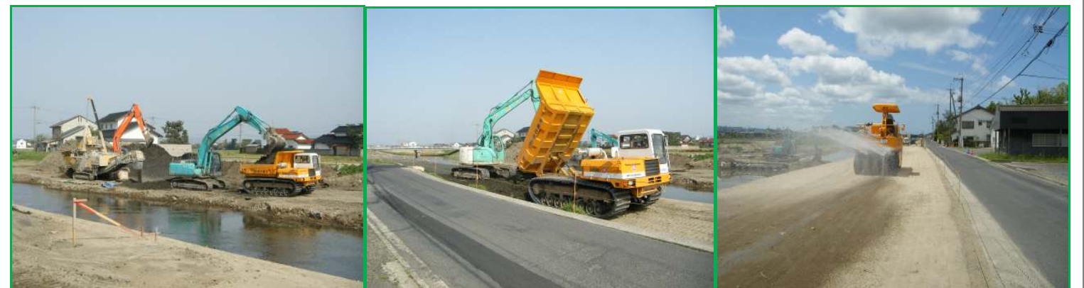
1、盛土材料の土質改良、積込
