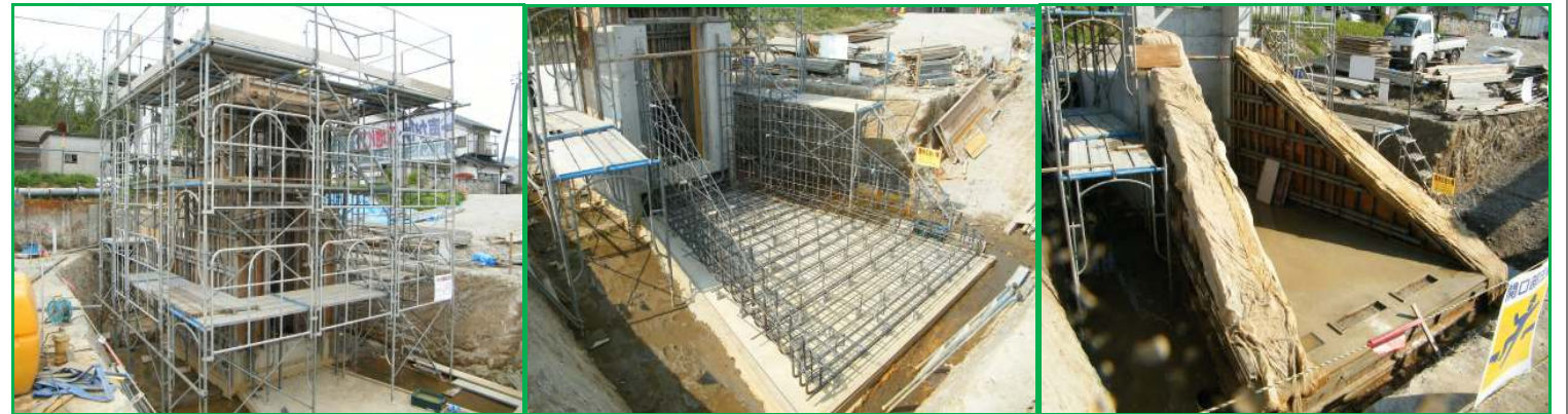
1、門柱・操作台型枠・コンクリート
