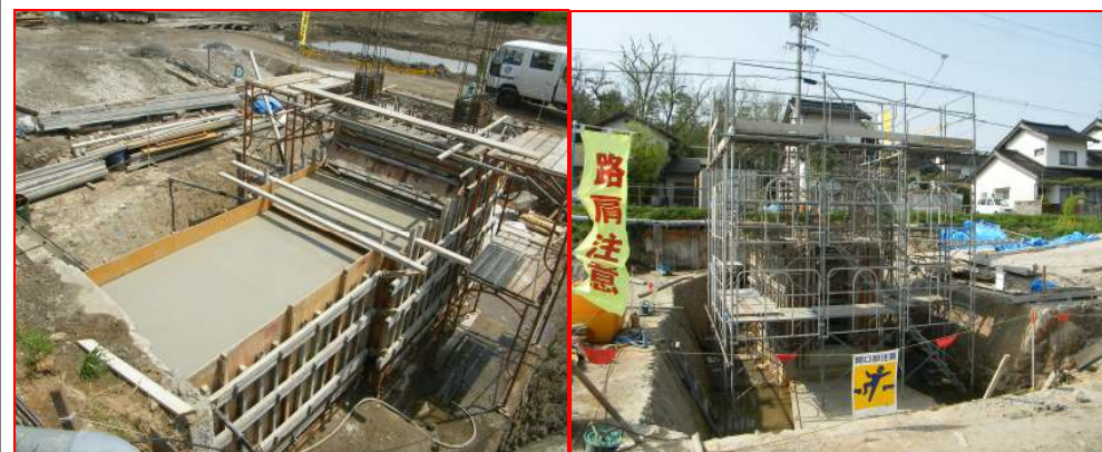
⑦コンクリート打設(函渠・門柱部)※門柱途中まで
