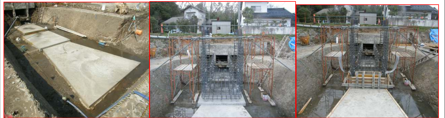
① 均しコンクリート(全体)
