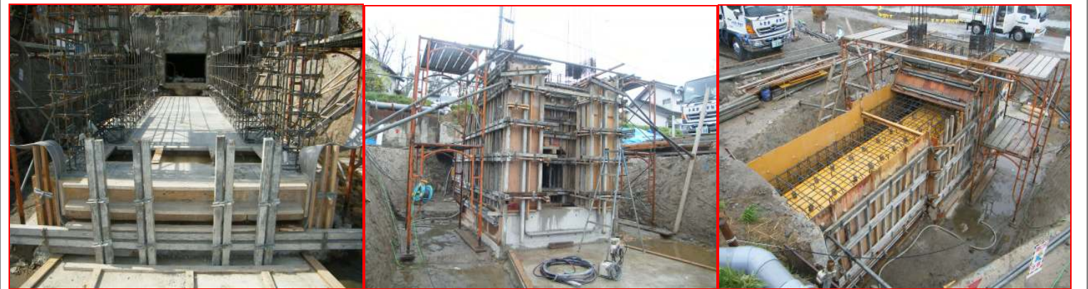
④コンクリート打設(函渠・門柱部)底板
