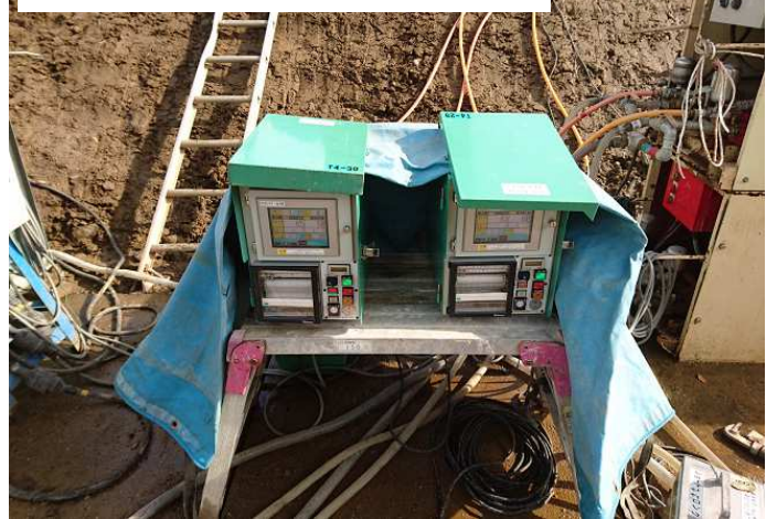
送り出した薬液量を管理する流量計
