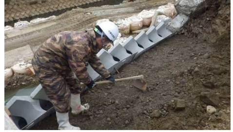
⑨裏込砕石・埋戻し土砂転圧状況
