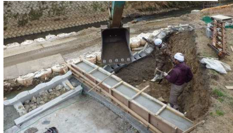
⑧コンクリート締固め状況
