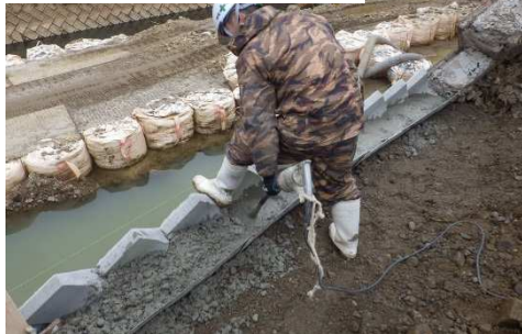
⑧コンクリート締固め状況
