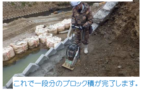
⑨裏込砕石・埋戻し土砂転圧状況
