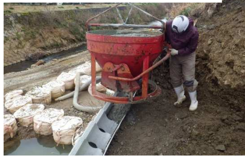
⑦ブロックの胸込コンクリート打設
