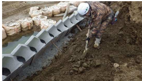
⑦ブロックの胸込コンクリート打設
