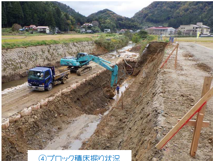
④ブロック積床掘り状況
