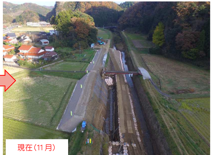
⑤ブロック積 基礎コンクリート打設完了→
