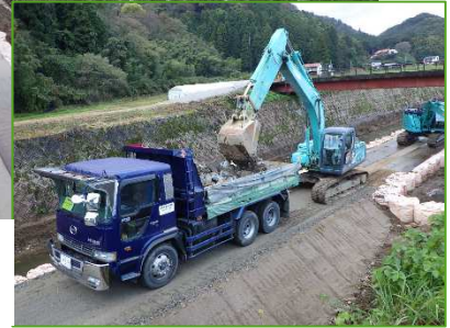
③取壊したブロックを ダンプに積み込み・搬出→
