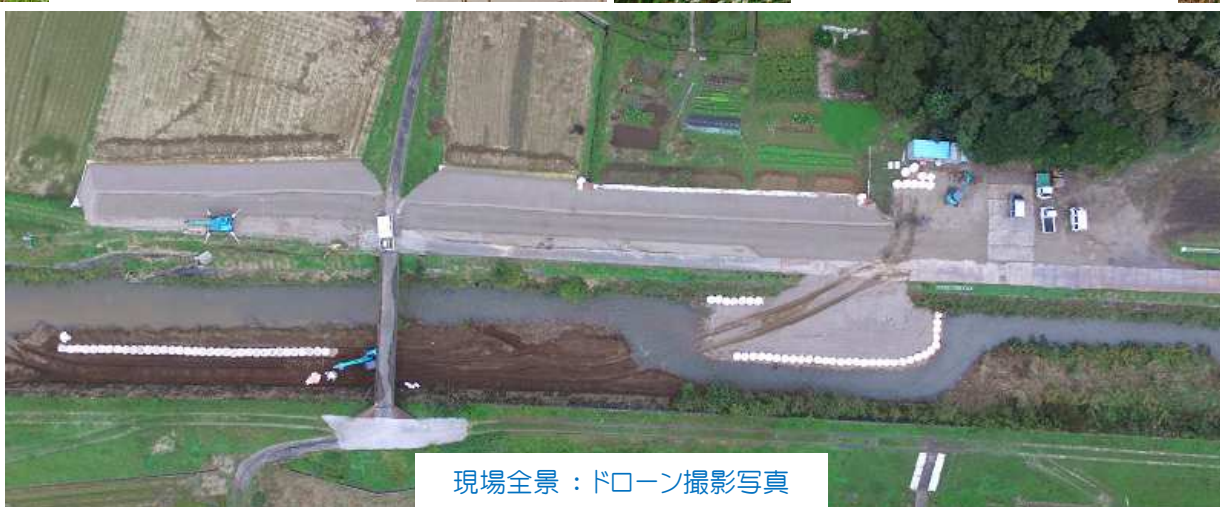
大型土のう 設置完了部分
