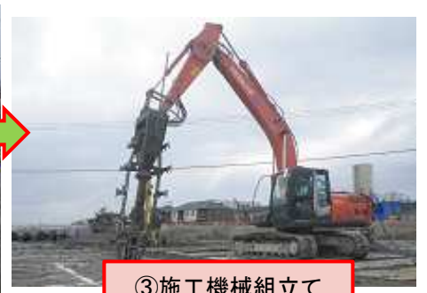
③ 施工機械組立て
