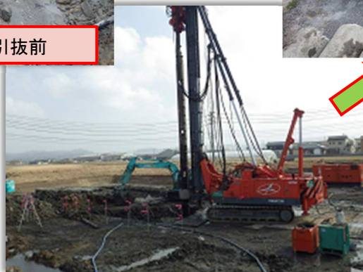
② コンクリート杭 引抜作業
