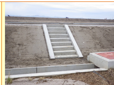
② 左記埋戻し完了後、北側に階段設置 （管渠の埋戻し完了後に北側の法面へ階段を設け昇降できるようにしました。）
