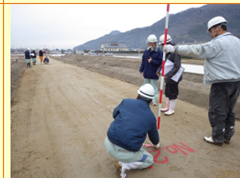
⑧ 部分使用検査 （完成した部分は検査を受け、合格の後、舗装業者へ引渡しました。）
