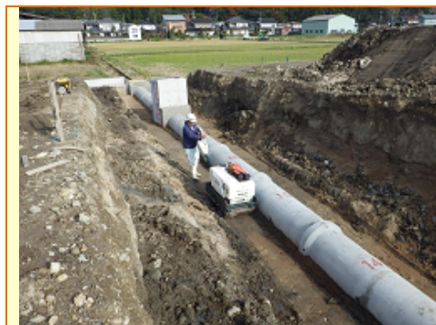
① 古山牧場 東側 排水管渠 埋戻し （管渠の接続が完了し、埋戻しの転圧を行っている状況写真です。）
