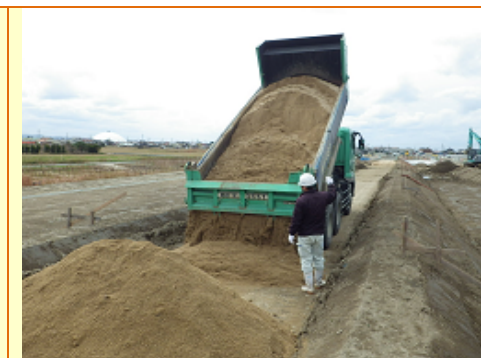
③ 路床盛土作業 （道路となる路床部分に盛土材を大型ダンプトラックで運搬し配っている状況写真です。）
