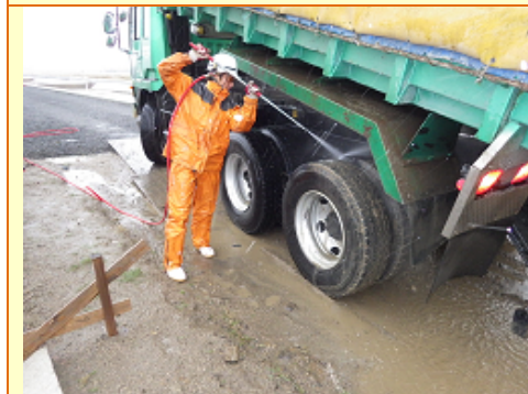
④ ダンプトラックのタイヤ清掃 （悪天候続きで現場内はぬかるんだ状態のため、一般道へ出る際タイヤを 1 本ずつ高圧洗浄し道路を汚さないようにしました。）
