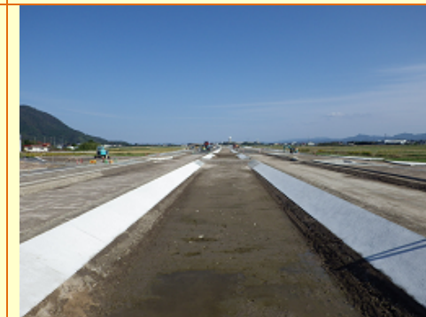
⑥ 防草対策コンクリート （防草対策コンクリートについては最終的に面積として 4,814m 2 、コンクリート量にして 481m 3 打設した事になりました。）
