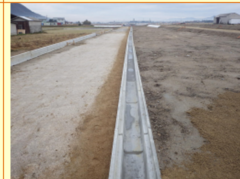
⑤ 道路側溝設置 （道路側溝については最終的に合計 1.3km 設置しました。）
